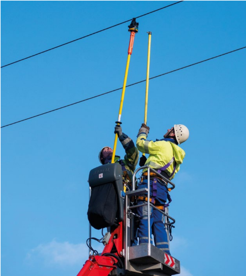
Bild 2. Einfach zu installieren: Mit einer Isolierstange werden die Smart Navigator 2.0 Kurzschlussanzeiger ohne Spannungsabschaltung in die Freileitung eingehängt.
